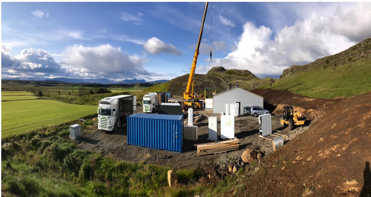
Mynd 4 Framkvæmdir Varmaorku við Kópavatn
