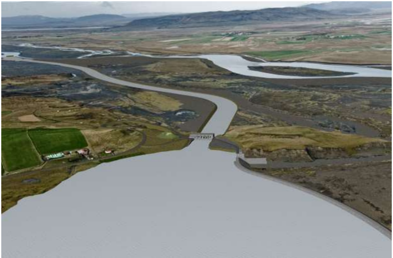
Mynd 1 Inntakslón, stöðvarhús, stífla og frárennslisskurður. Horft yfir á Árnnessporð.
