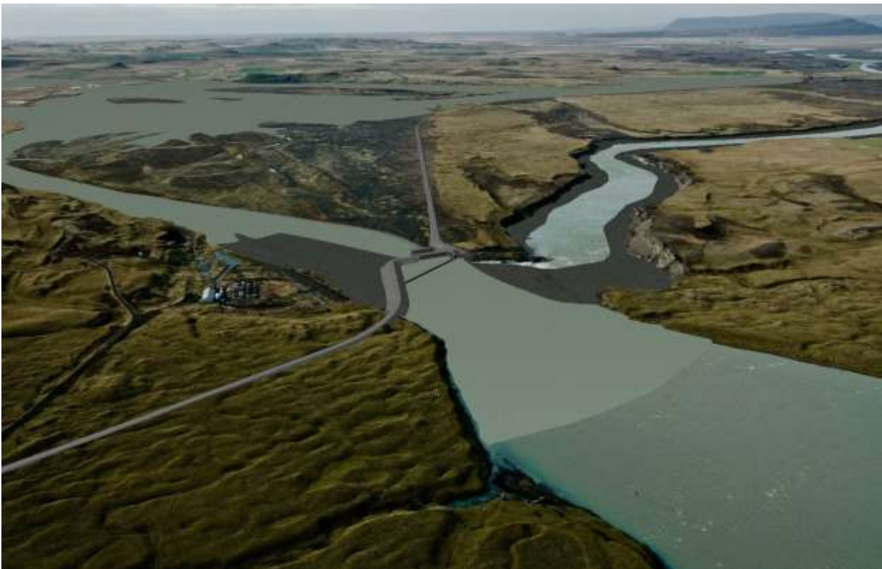
5.3 Horft yfir Árneseyju með Árneshólum. Veitumannvirki eru í forgrunni, stöðvarhúsi lengst til hægri.
