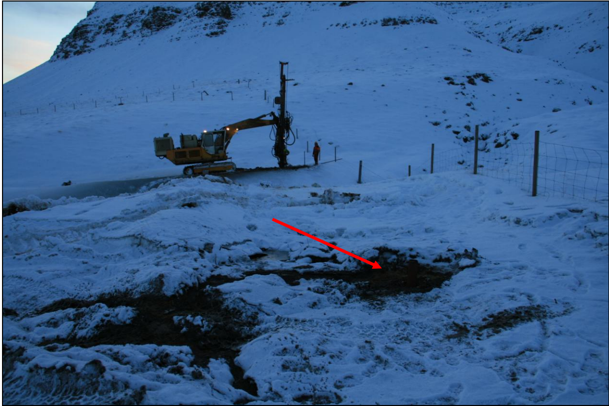
13. mynd. Borun holu BK-07 stendur yfir. Borhola BK-06 í forgrunni.
