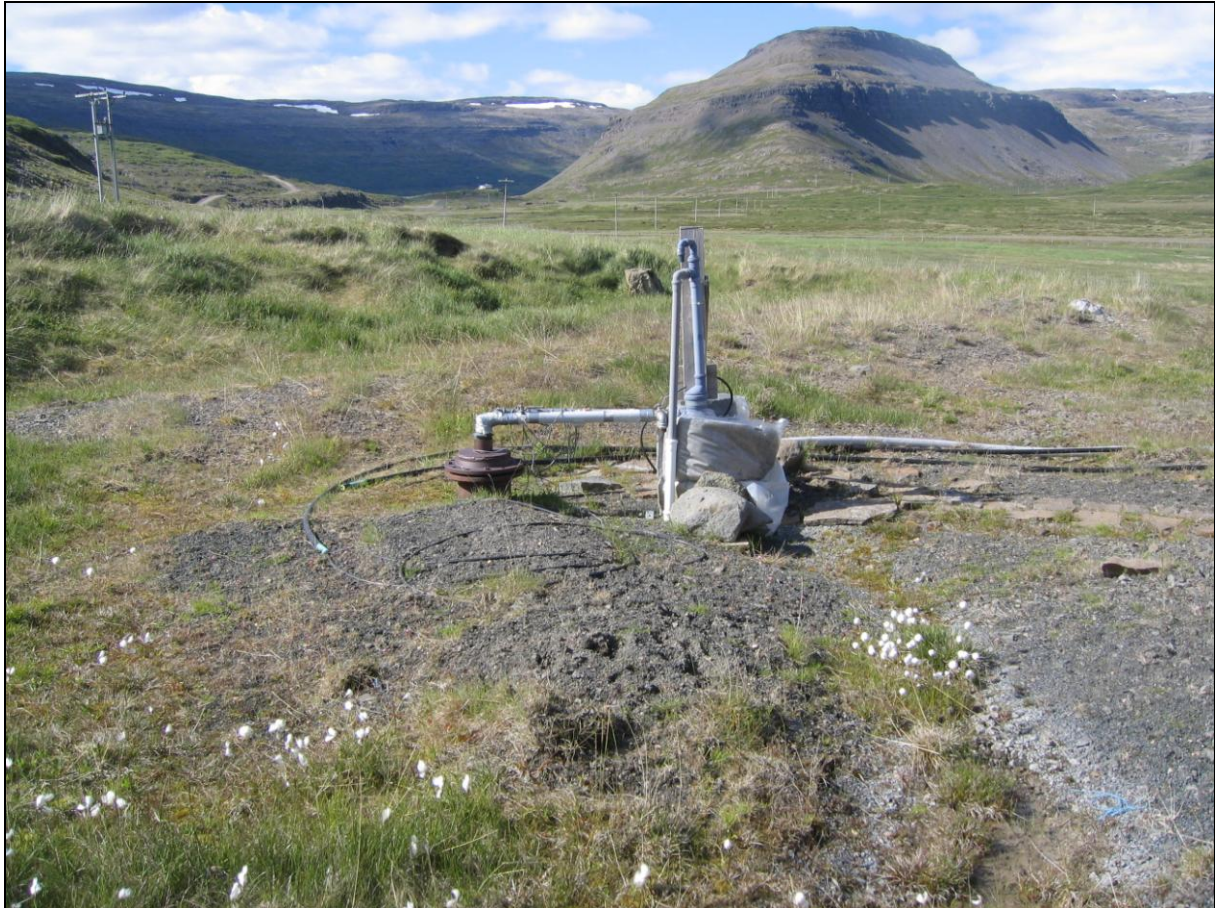
19. mynd. Borhola BO-01 í Kleifarkoti. Horft fram dalinn.
